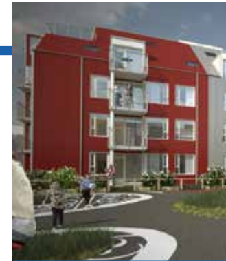
Naustabryggja 31-33 30 íbúðir í Bryggjuhverfi 30 apartments in Bryggjuhverfi
